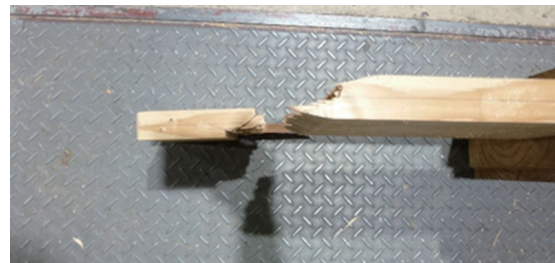
解体後・NO1の竿の状況
