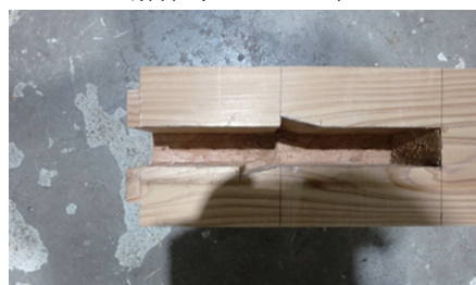
解体時・NO.3 の女木の状況
