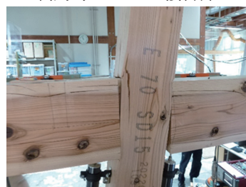
終局時・NO.3 の柱の破壊
