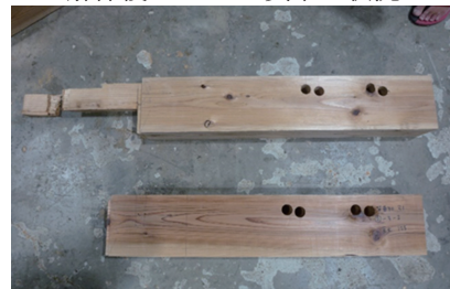
解体後・NO2 の破壊性状
