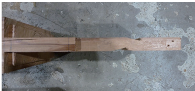
解体後・NO1 の男木の状況
