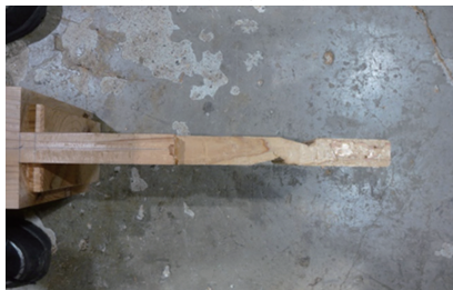
解体後・NO1 の男木の状況
