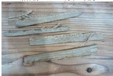
解体後・NO.1 の車知の状況
