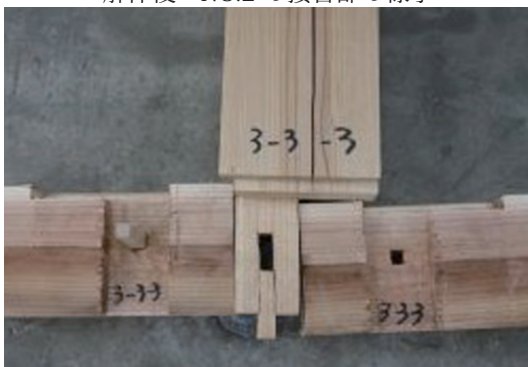
解体後・NO.3 の接合部の様子
