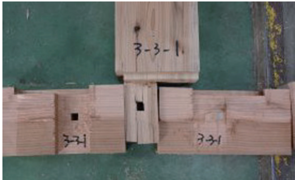
解体後・NO.1 の接合部の様子
