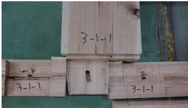
解体後・NO.1 の破壊性状
