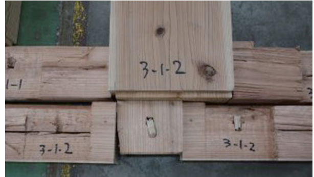
解体後・NO.2 の破壊性状
