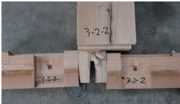
解体後・NO.2 の様子
