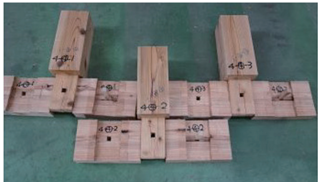
解体後・接合部の様子
