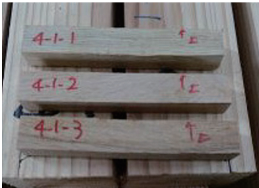
解体後・込み栓の様子
