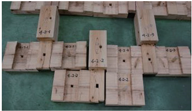
解体後・接合部の様子
