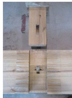
解体後・NO.3 曲げ折れた た込み栓とめり込み跡
