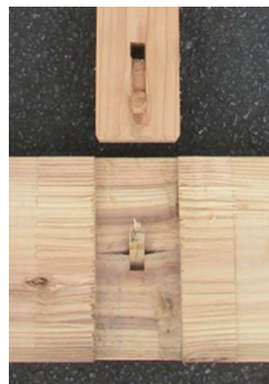
解体後・NO.1 曲げ折れた た込み栓とめり込み跡
