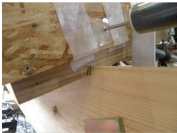
垂木-桁接合部
